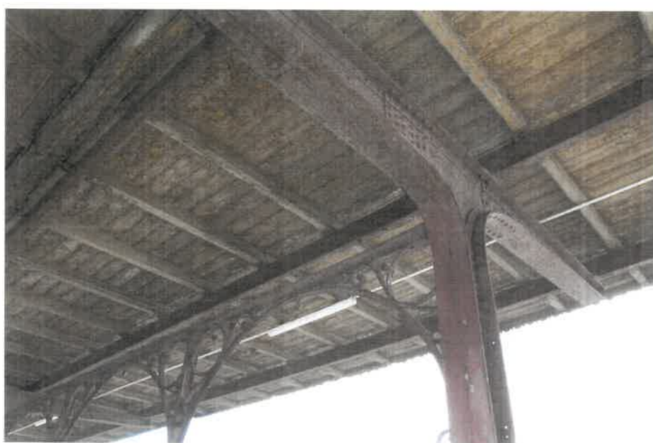
Fot. 12. Fragment konstrukcji stalowej wiaty peronowej.
