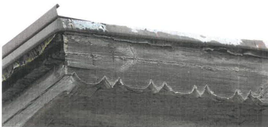
Fot. 8. Fragment oryginalnej wiatrownicy od strony bocznej wschodniej.
