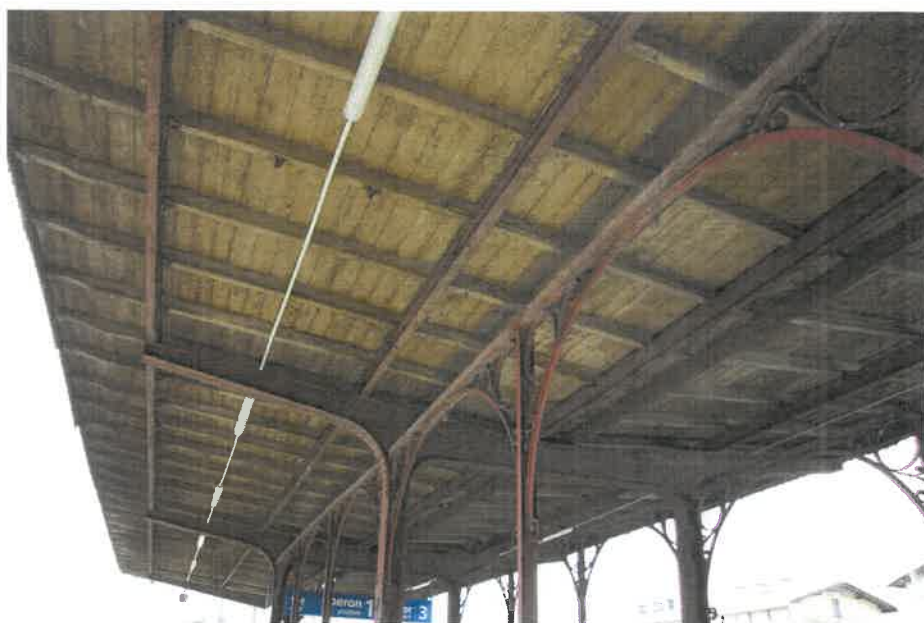
Fot. 11. Fragment konstrukcji stalowej wiaty peronowej.
